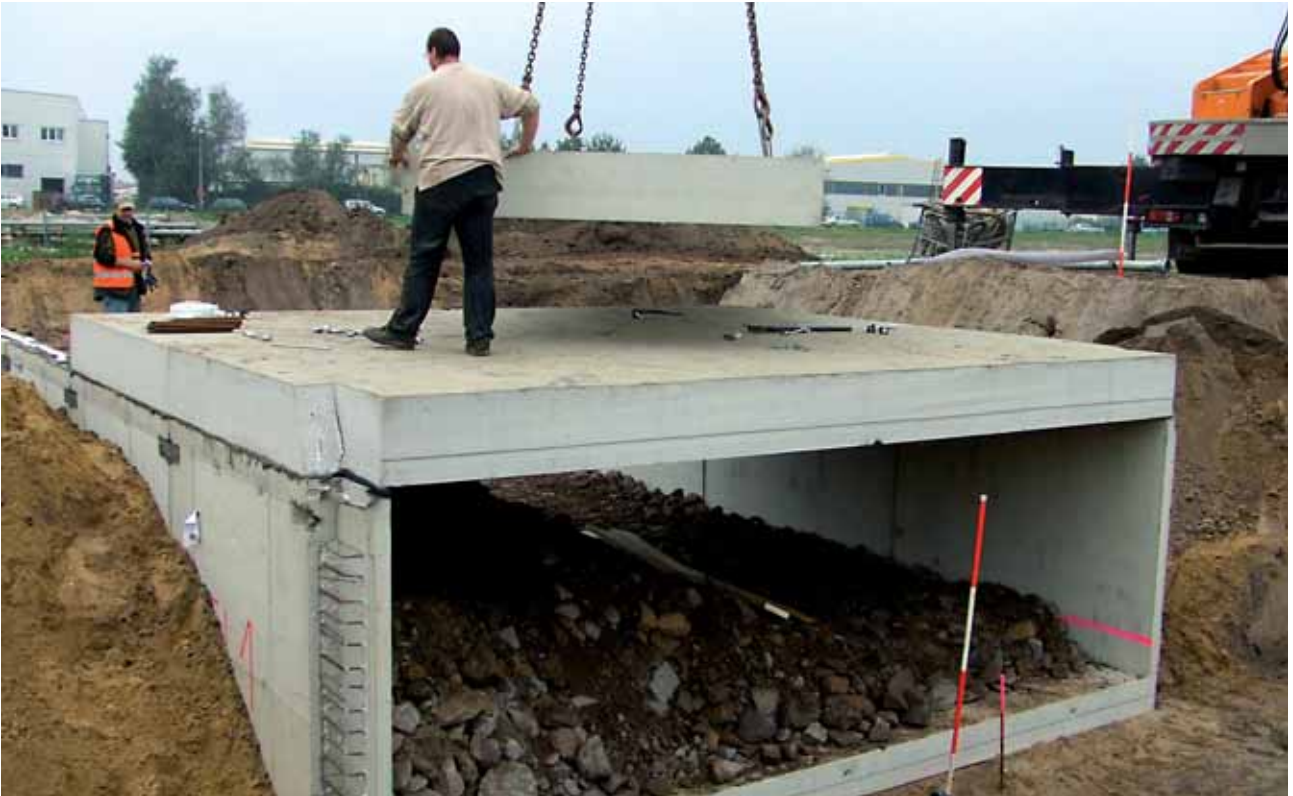
Montage der Deckenplatten druckwasserhaltend untereinander verspannt. Einzelgewichte je Deckenplatte ca. 15,5 to
