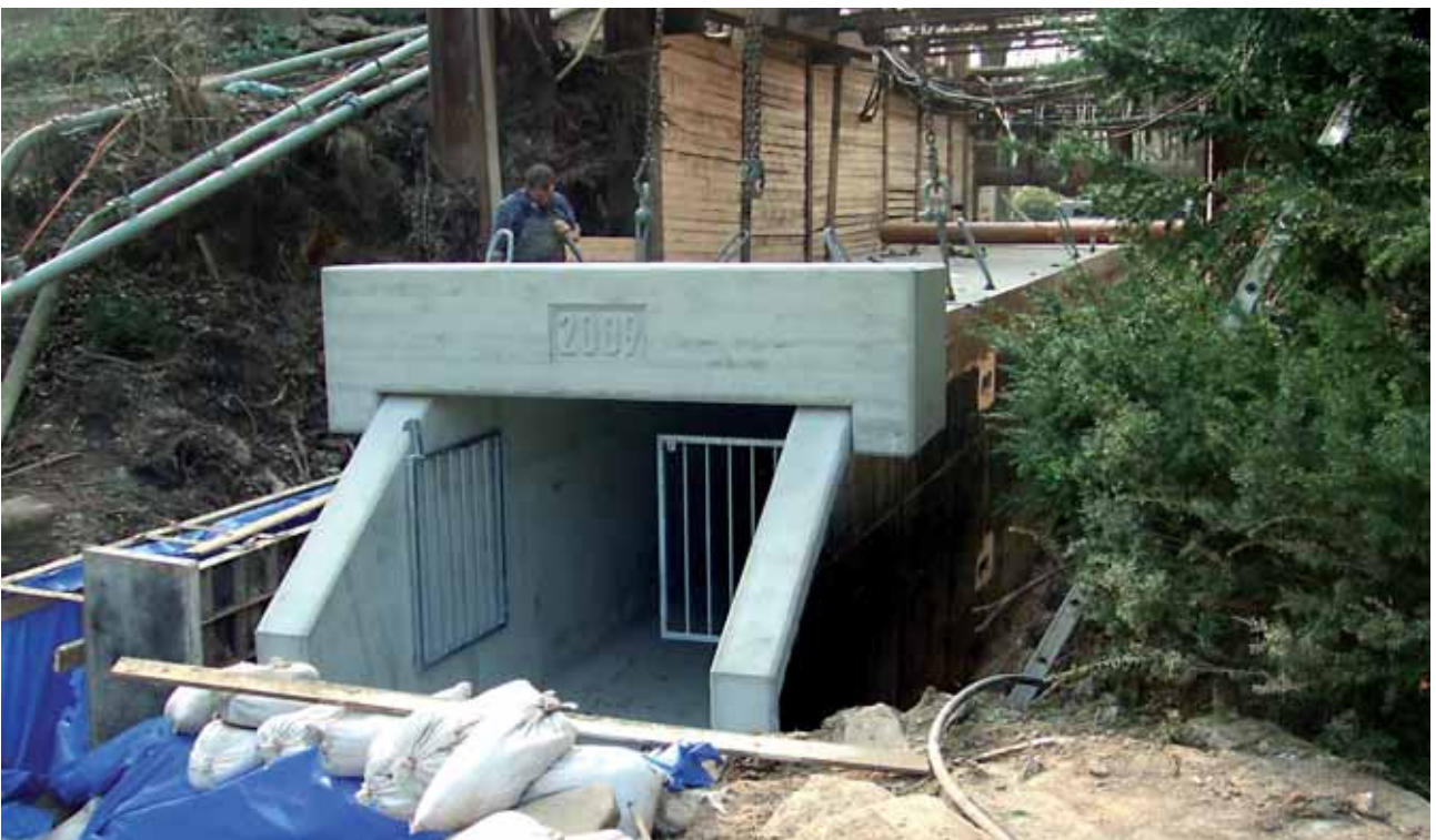
Einlaufteil mit Gittertür und Kappe mit Brettstruktur und Jahreszahl
