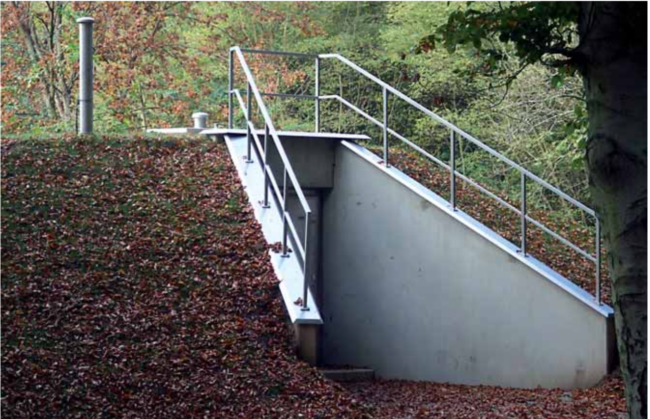
Flügelwände mit Edelstahlabdeckung
