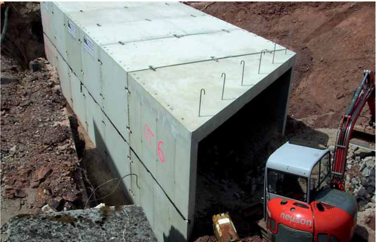
Einbau der U-Teile obere Lage
