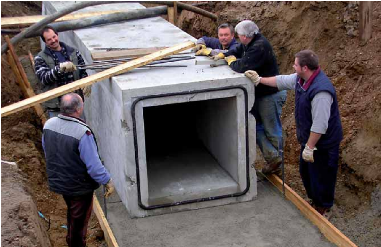
Ausgerichtetes Bauteil mit aufgeklebter Dichtung nach DIN 4060
