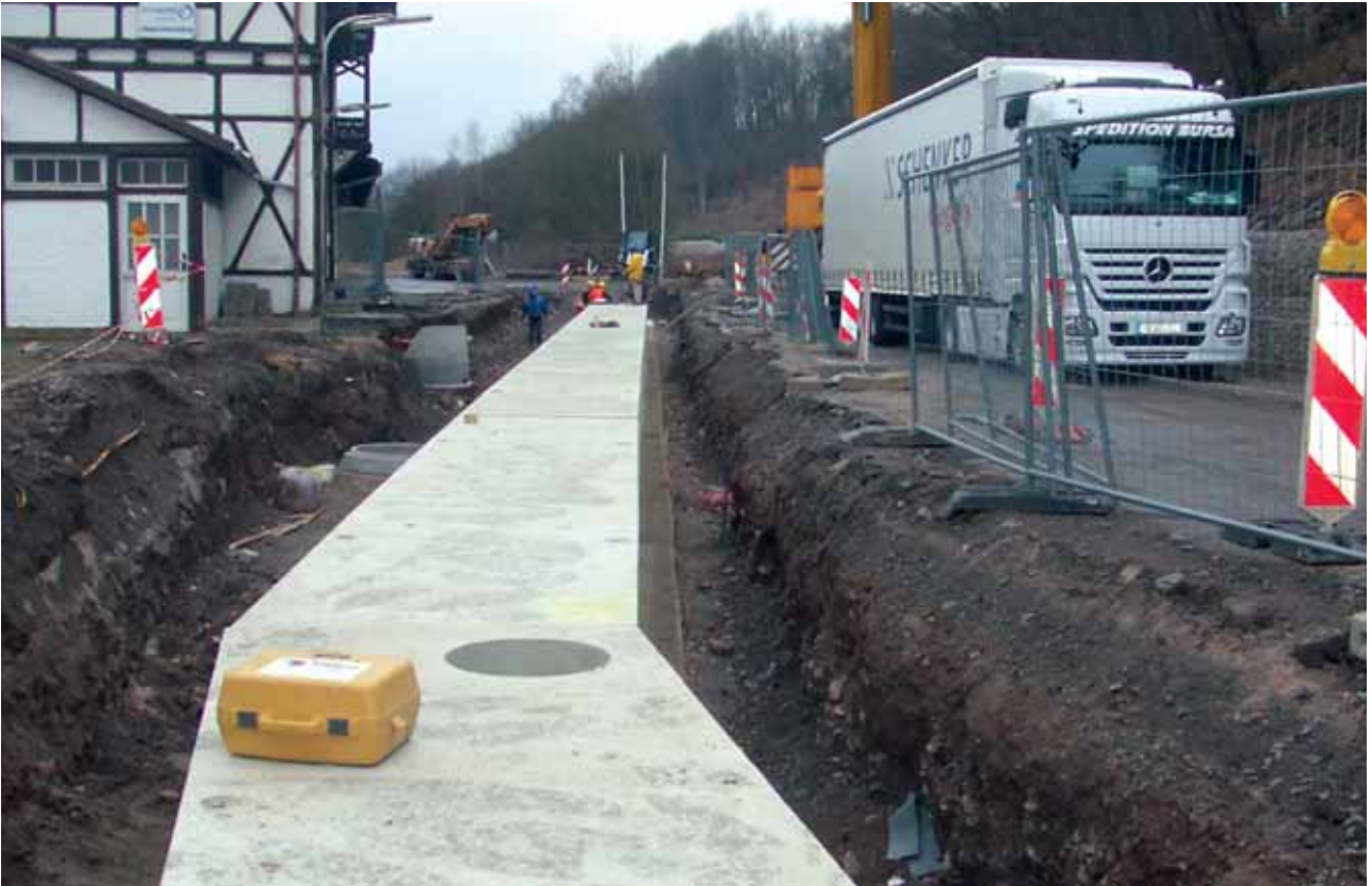
Bereits verlegte Rahmenelemente mit Krümmung und Einstiegsöffnung
