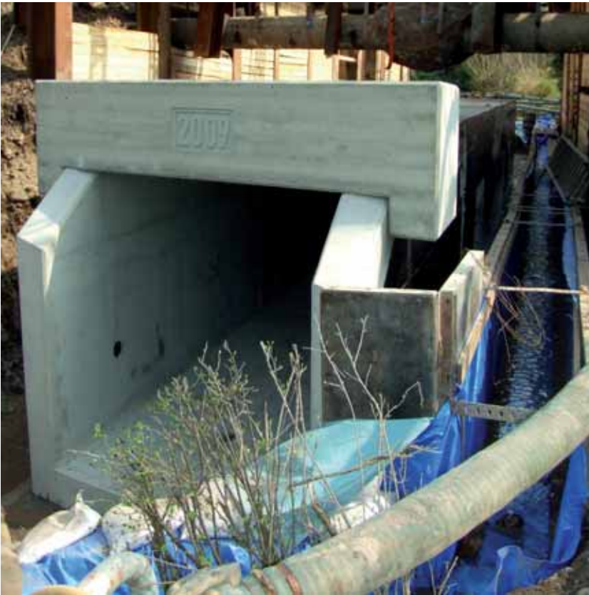
Auslaufteil mit Schrägschnitt, Kappe mit Brettstruktur und Jahreszahl
