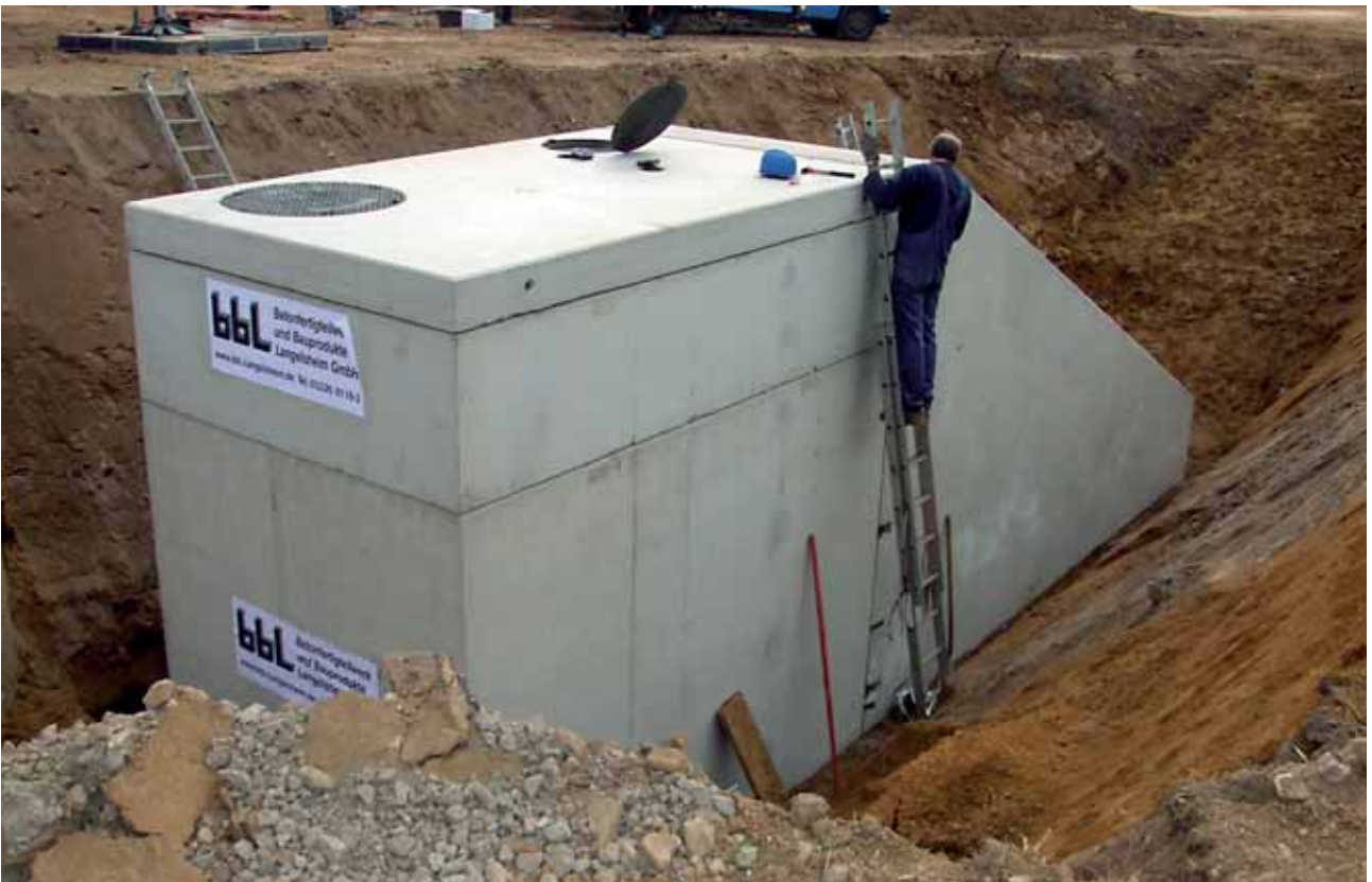
Einbau der Flügelwände mit Verspannung an das Bauwerk
