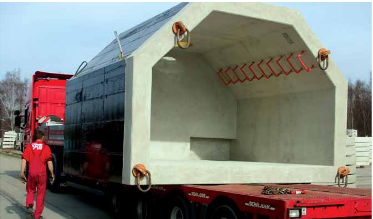
Lünen 2010 Übergabeschacht einteilig, sechseckig, verstärkte Wände für Steinkohlekraftwerk lichte Innenmaße l/b/h 355/240/320 cm
