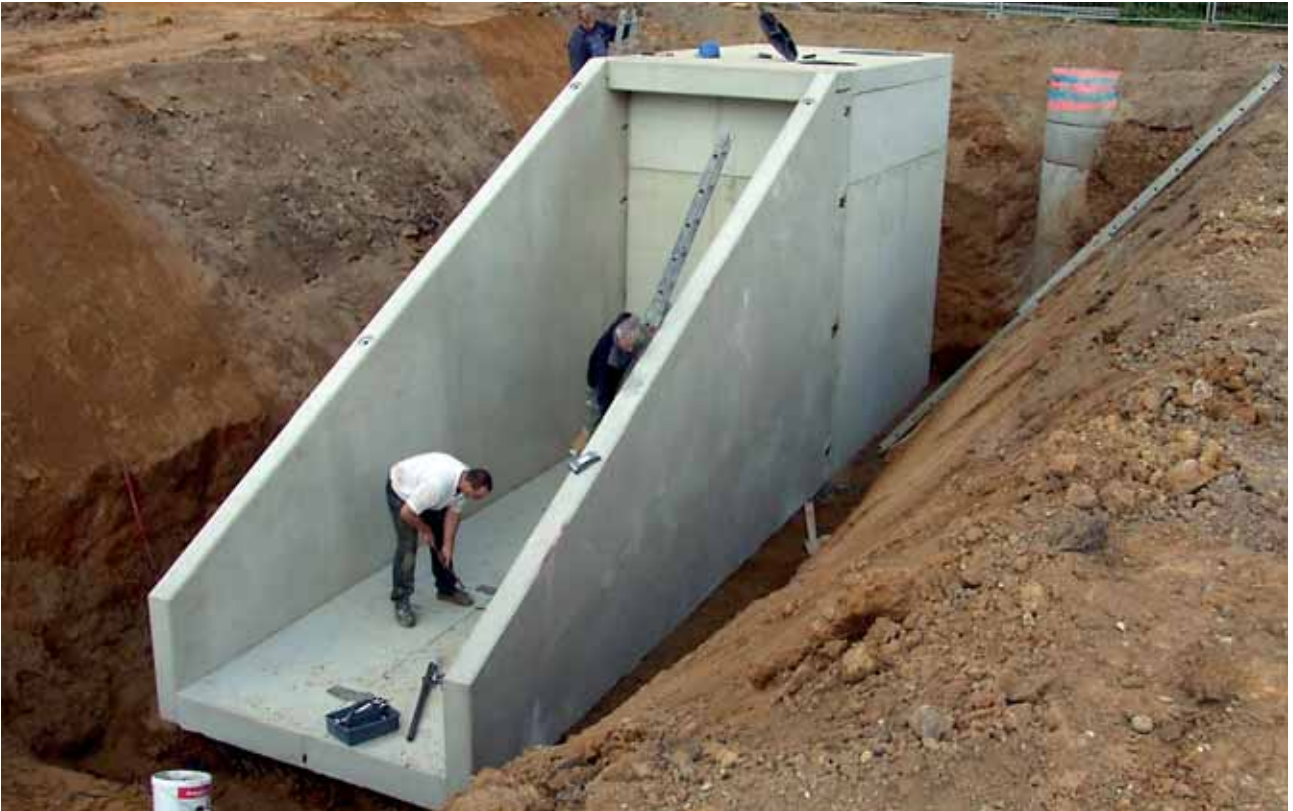
Verschrauben der Spannelemente
