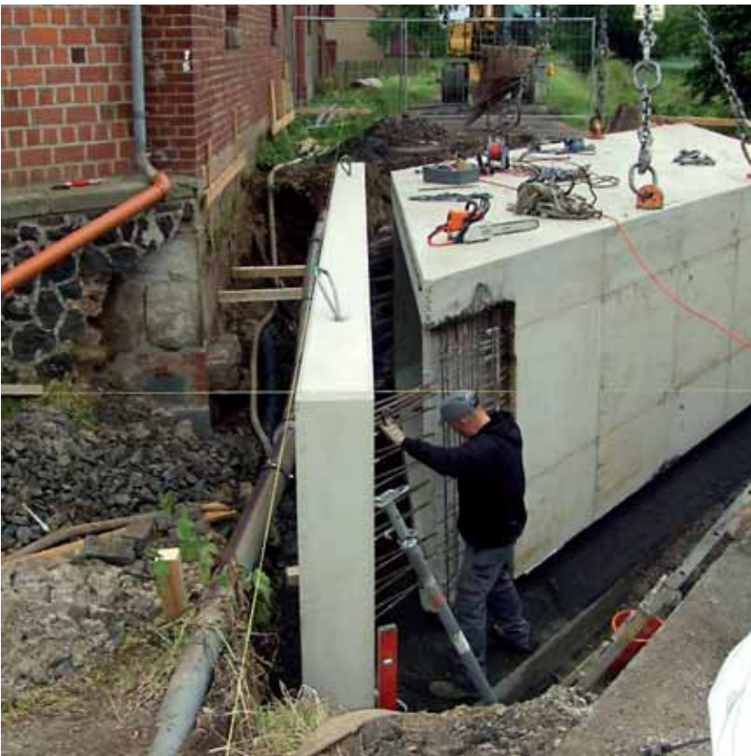
Einfädeln des Rahmenteils auf die Flügelwand unter beengten Platzverhältnissen
