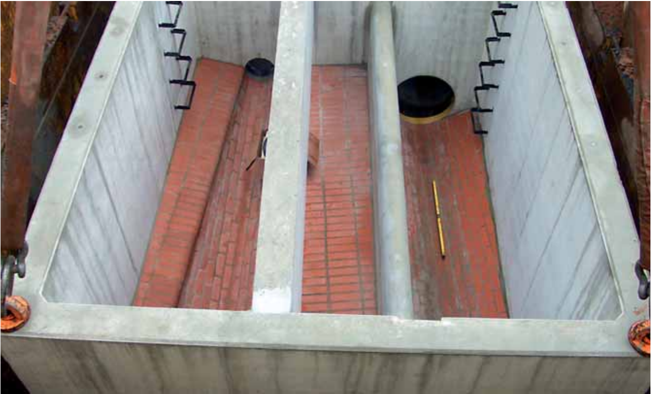
Körle Überlaufbauwerk einteilig, Trennwand, Überlaufschwelle, geklinkertes Gerinne, lichte Innenmaße l/b/h 500/335/255 cm
