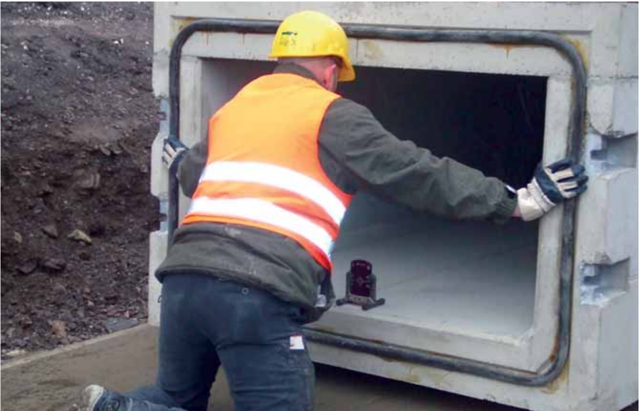
Ausrichten des Bauteils und Absetzen auf der Baugrubensohle
