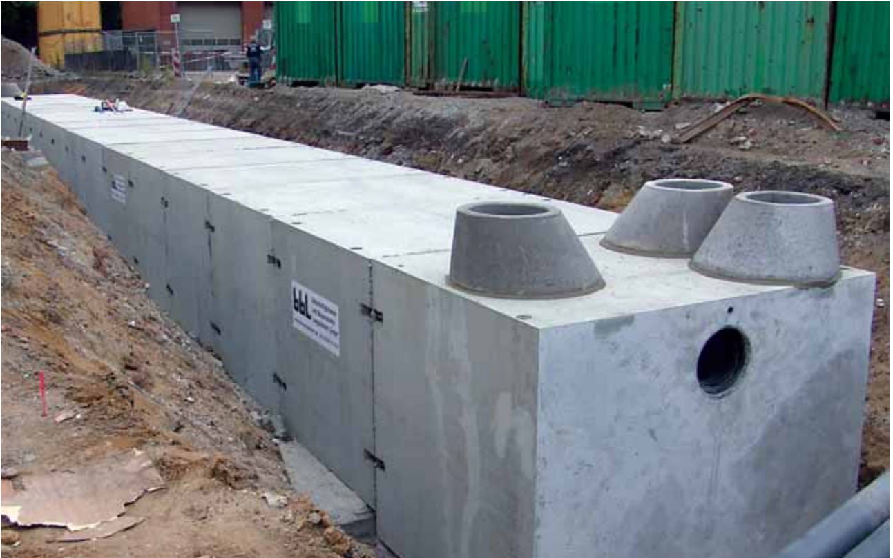
Speicherbecken fertig montiert Montagedauer ca. 8 Stunden.
