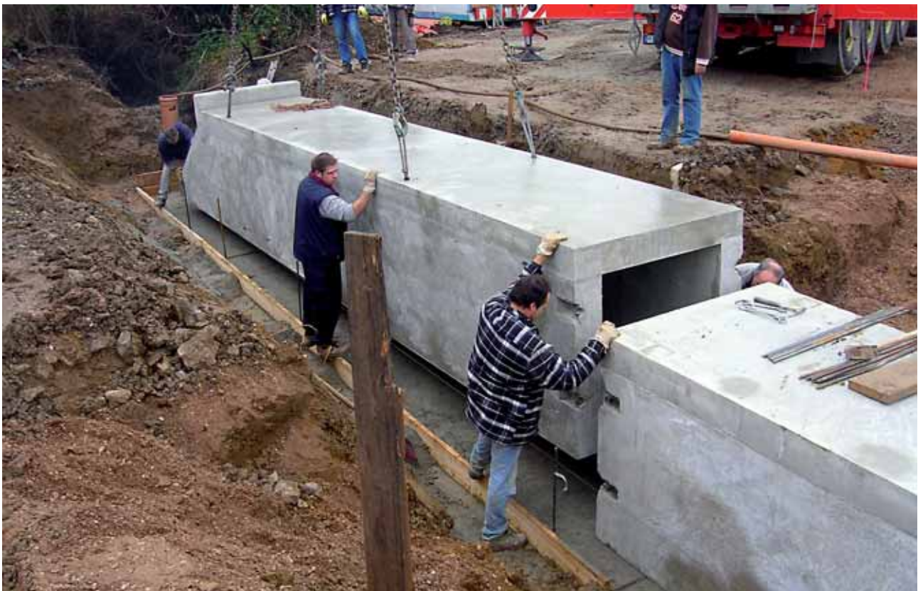
Einheben des zweiten Bauteils, Länge 9,50 m, Gewicht ca. 22,0 to
