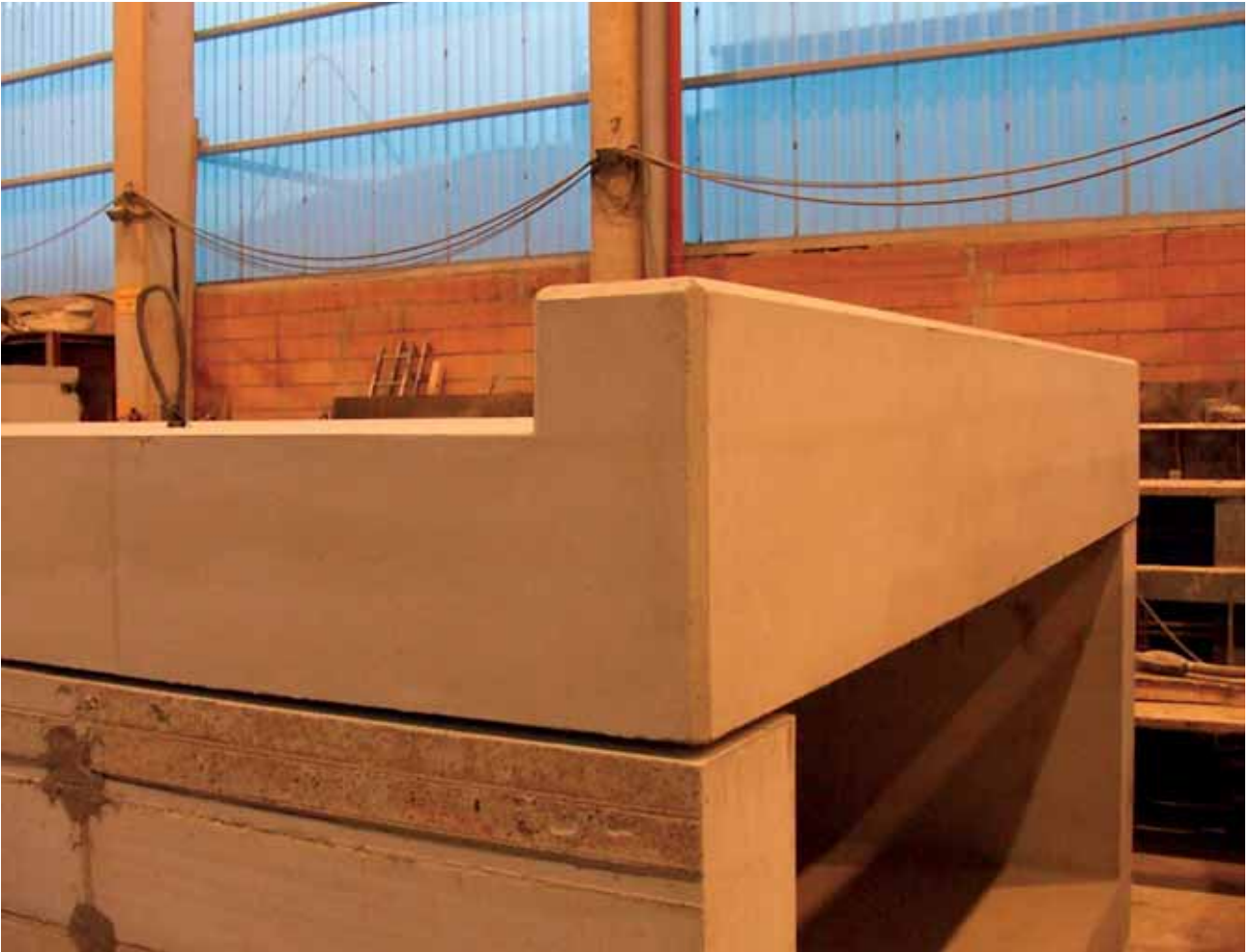
Montagedauer des Bauwerkes vor Ort ca. 1 Stunde.
