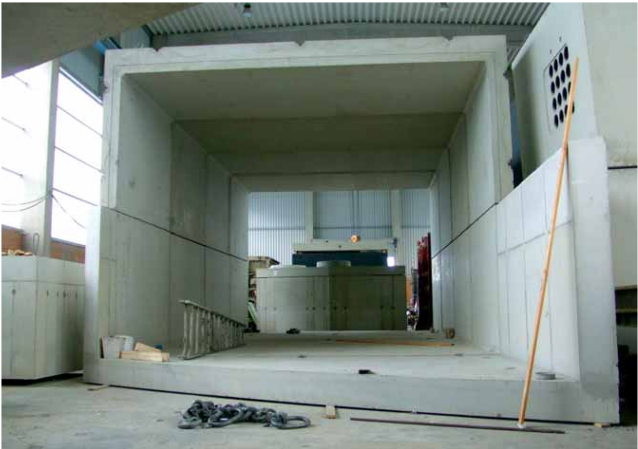
Vormontage und Passkontrolle im Werk
