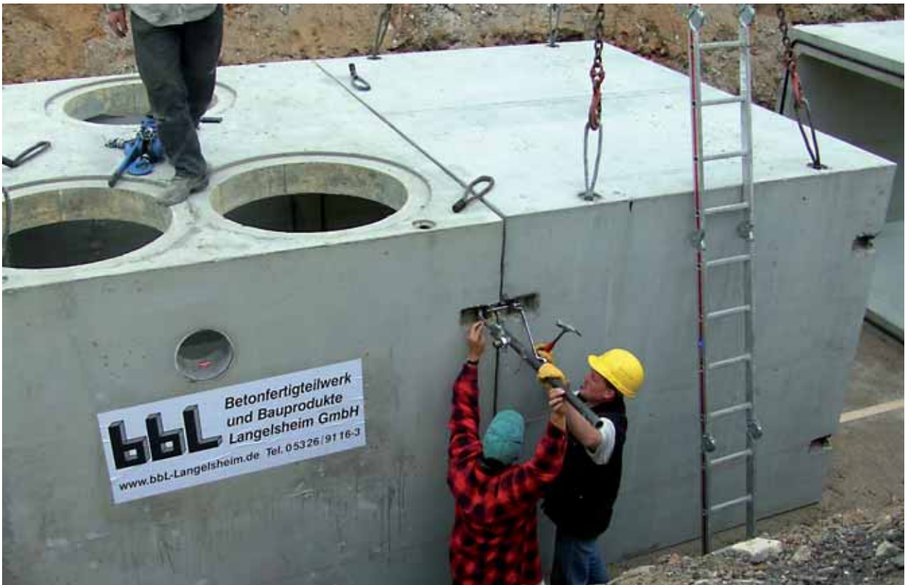
Druckwasserhaltende Verspannung der Rahmenelemente
