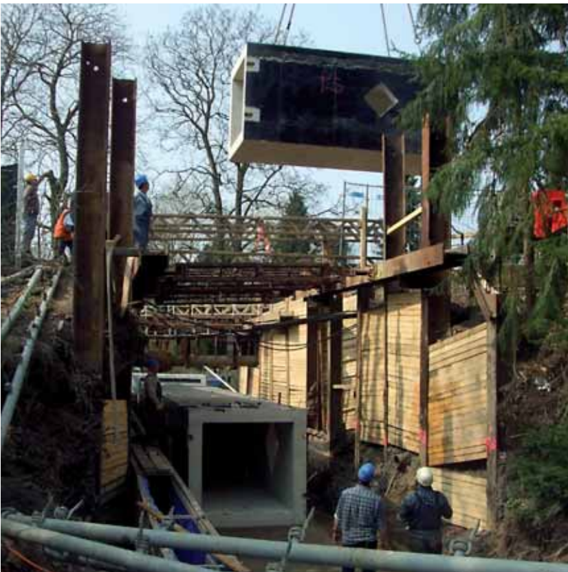
Einheben der weitem Elemente
