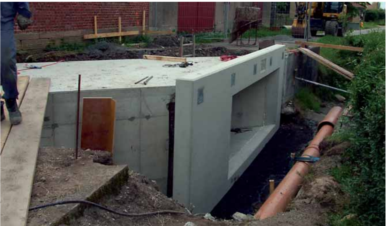
Montagedauer ca. 6 Stunden mit 3 Mann
