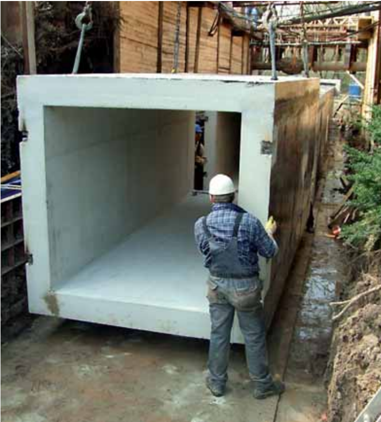
Einheben des nächsten Teiles, Einfädeln unter den Verbau
