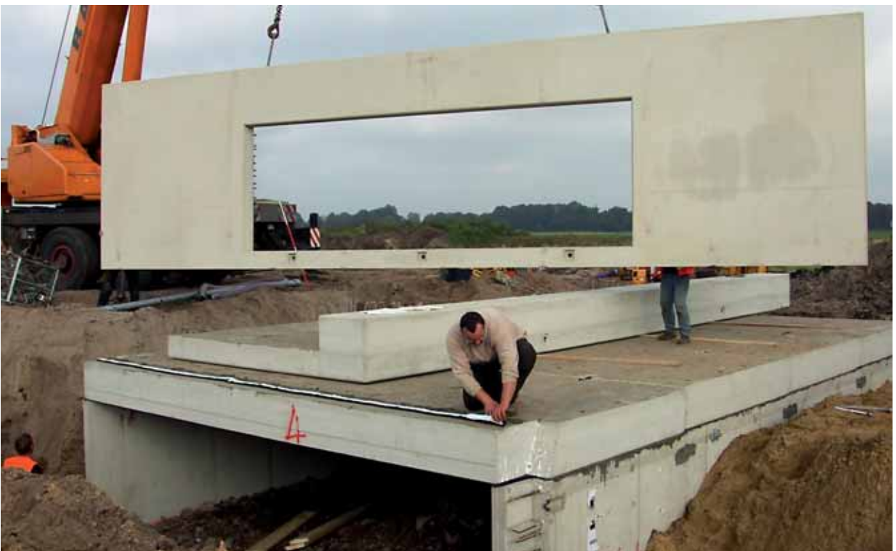
Montage der einteiligen Flügelwände mit angeformten Kappen Einzelgewicht der Flügelwände ca. 20,0 to
