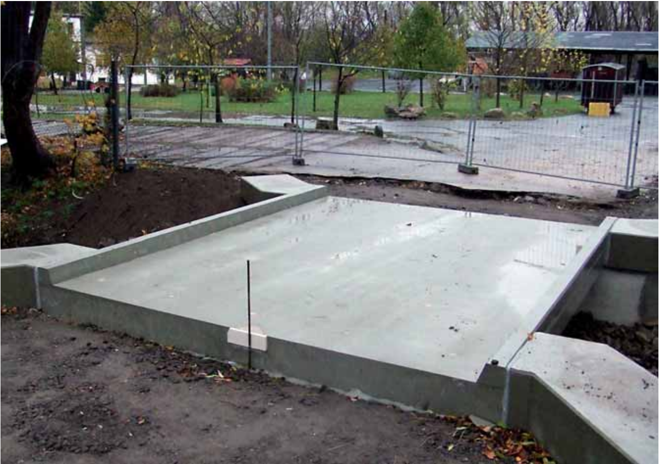
Brückenfertigteil auf Ortbetonfundament gelagert
