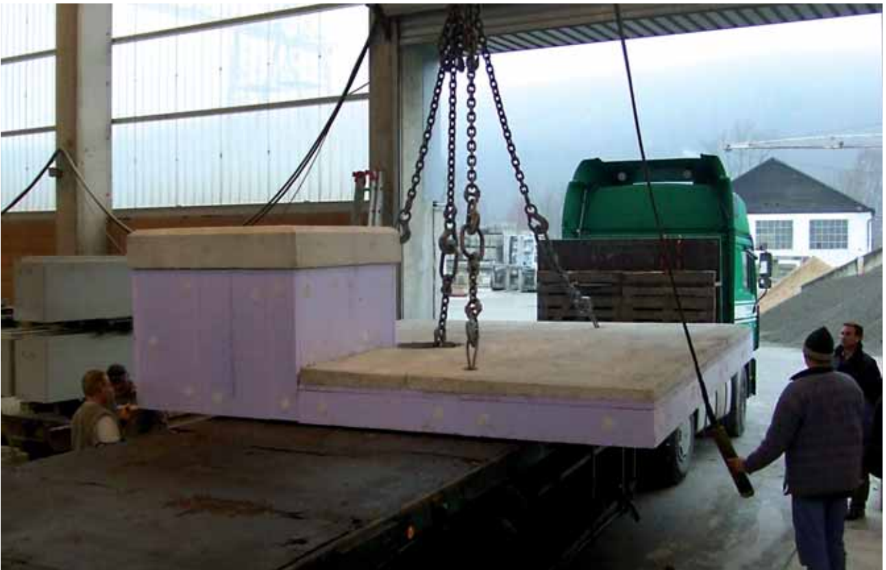
Deckenplatte mit Schachthals und Schachtvierung, mit Wärmedämmung und Schutzbeton
