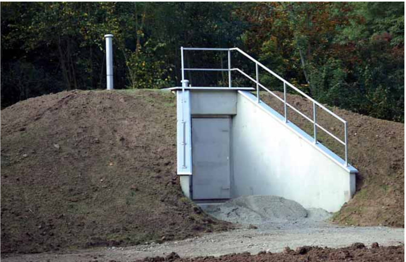
Flügelwände mit Edelstahlabdeckung
