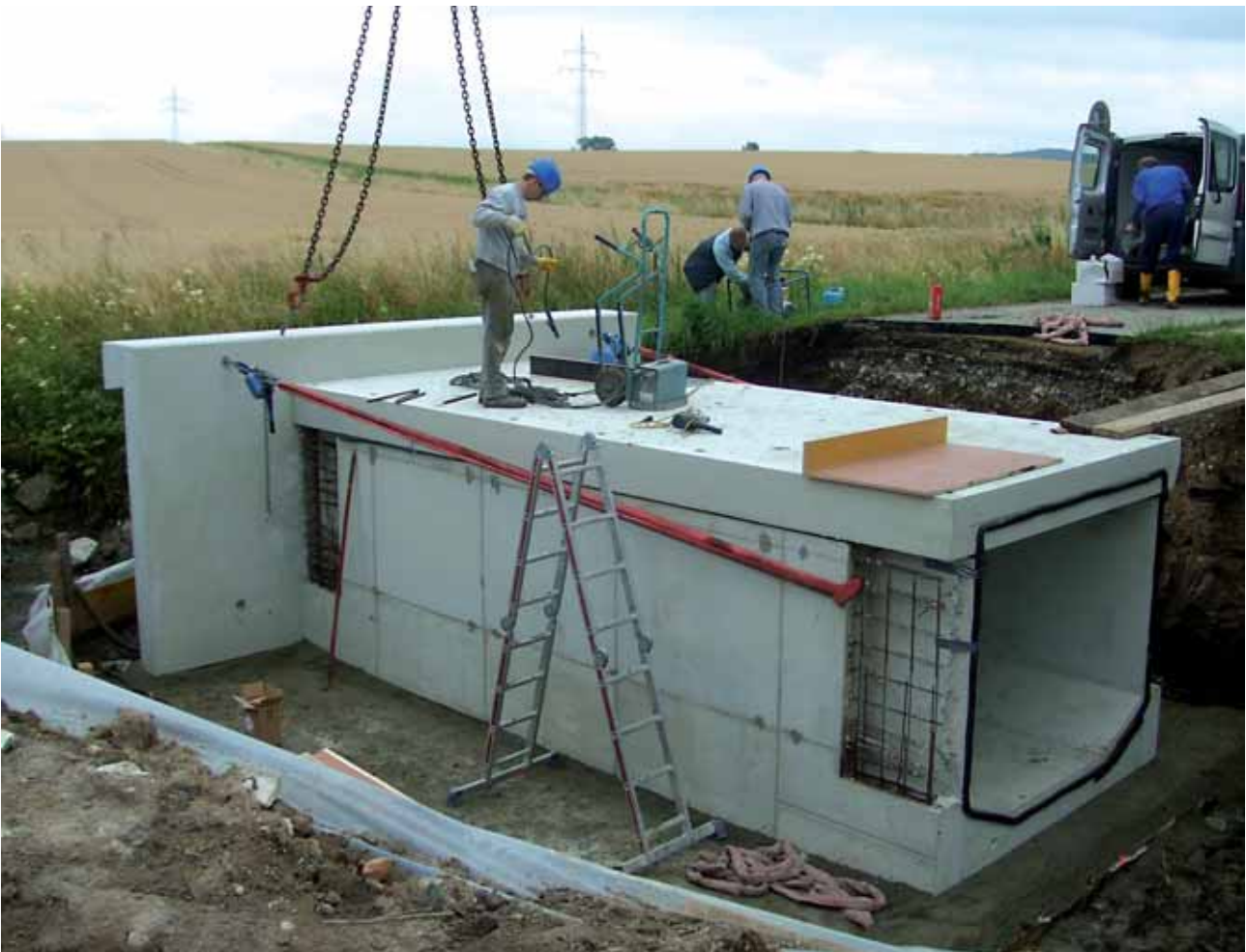
Einbau der Flügelwände
