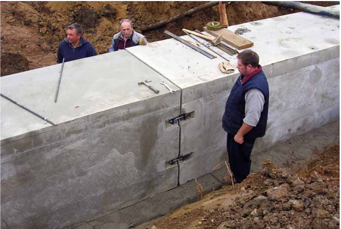
Beide Teile mit Spannschraubensätzen verbunden
