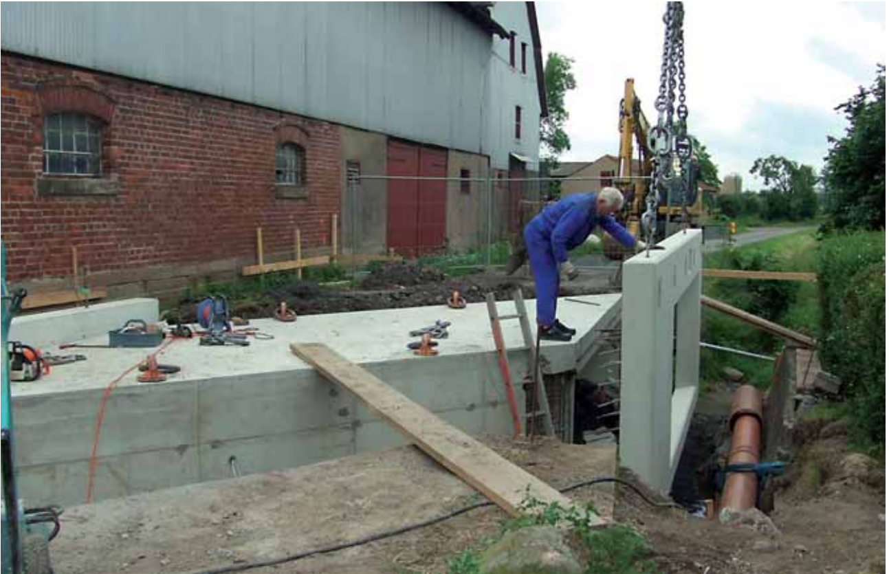
Einfädeln der zweiten Flügelwand auf das Rahmenteil, danach Vergießen der Bewehrungsanschlüsse
