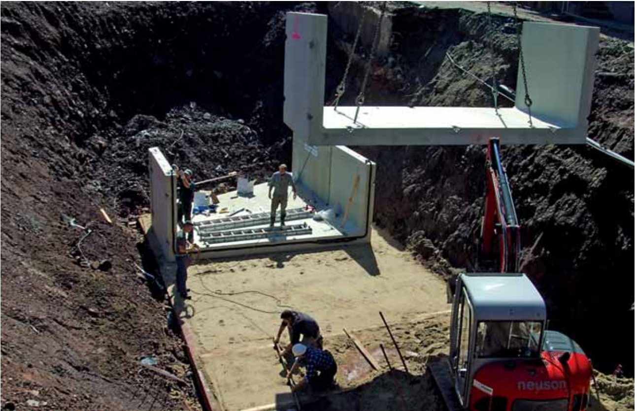
Einbau der U-Teile untere Lage auf vorbereiteter Baugrubensohle
