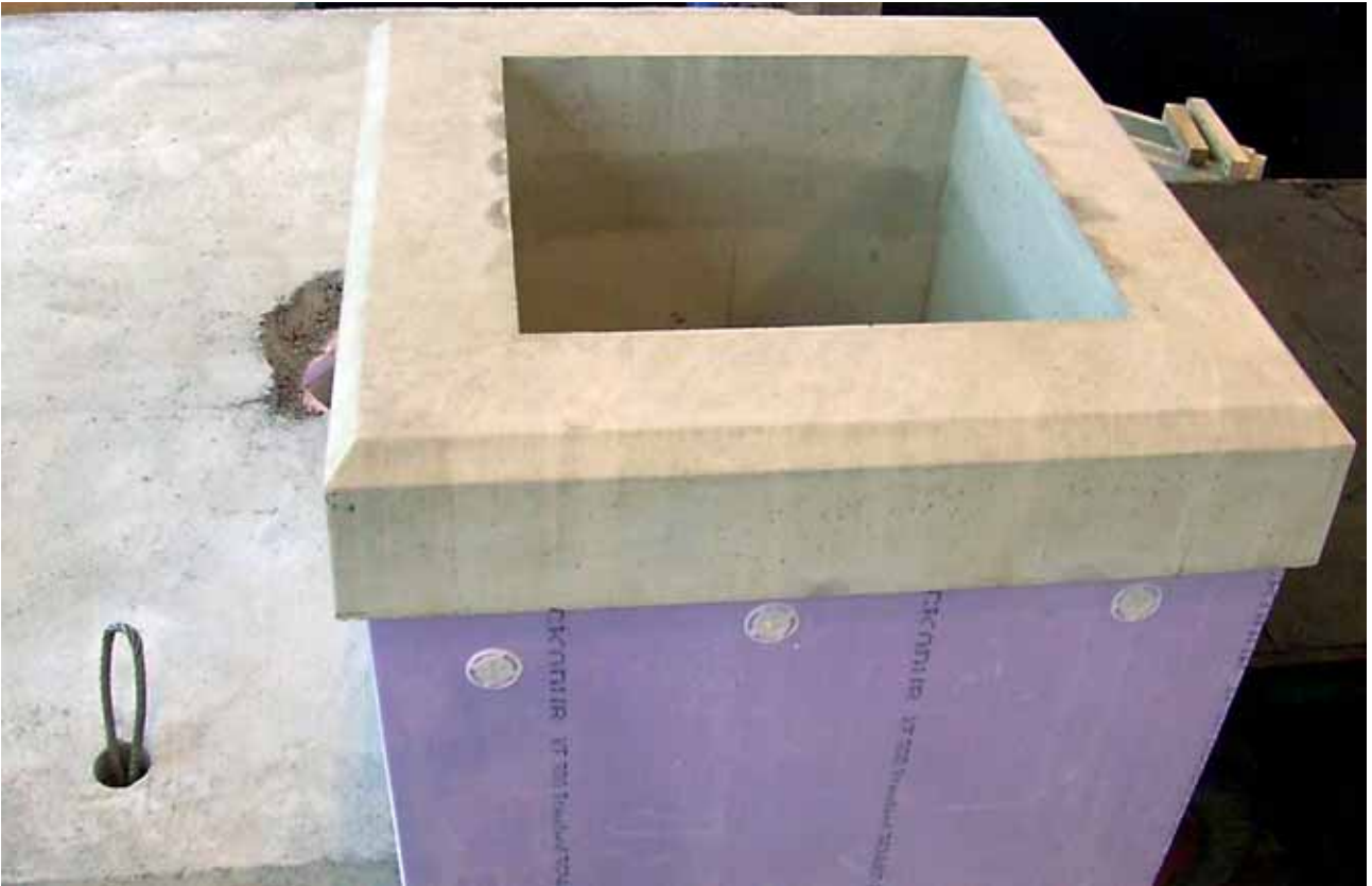
Deckenplatte mit Schachthals und Schachtvierung, mit Wärmedämmung und Schutzbeton
