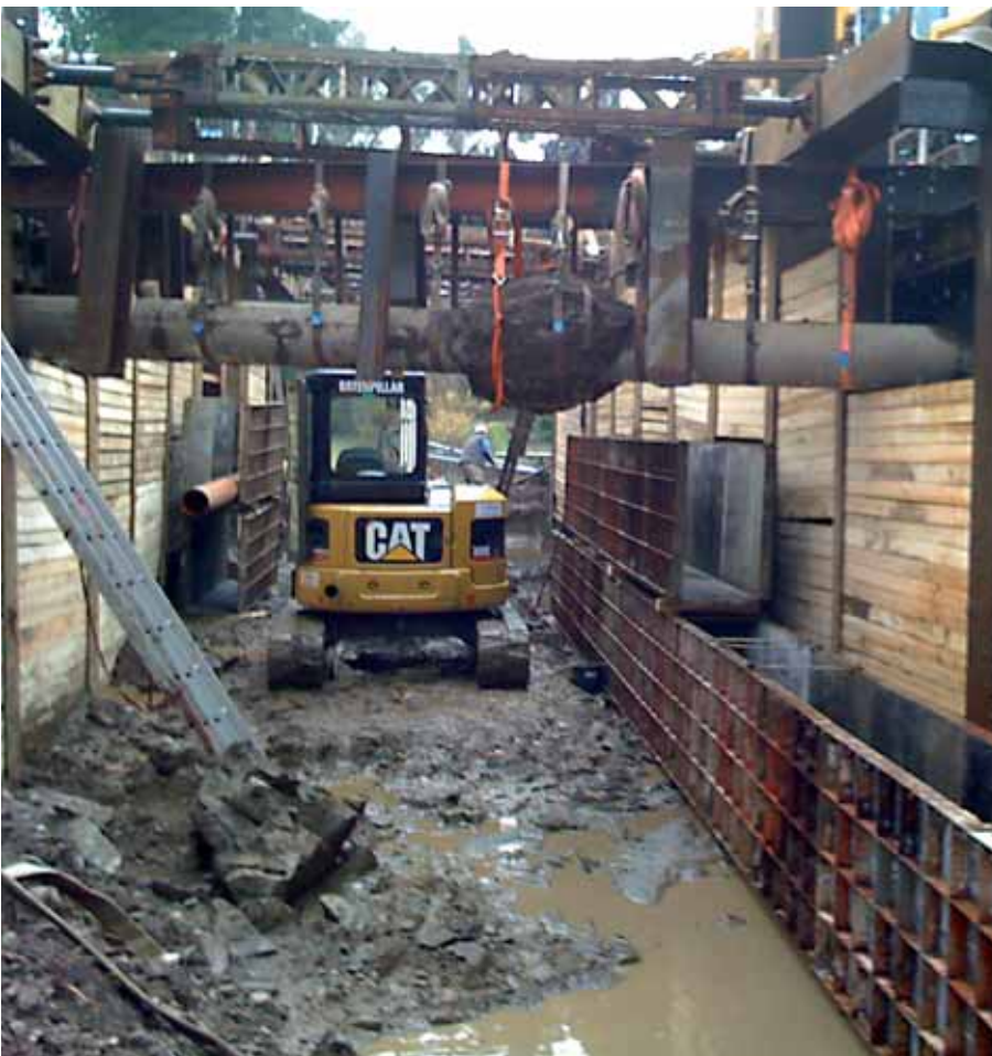
Erstellen der Baugrubensohle, Umleitung des Baches
