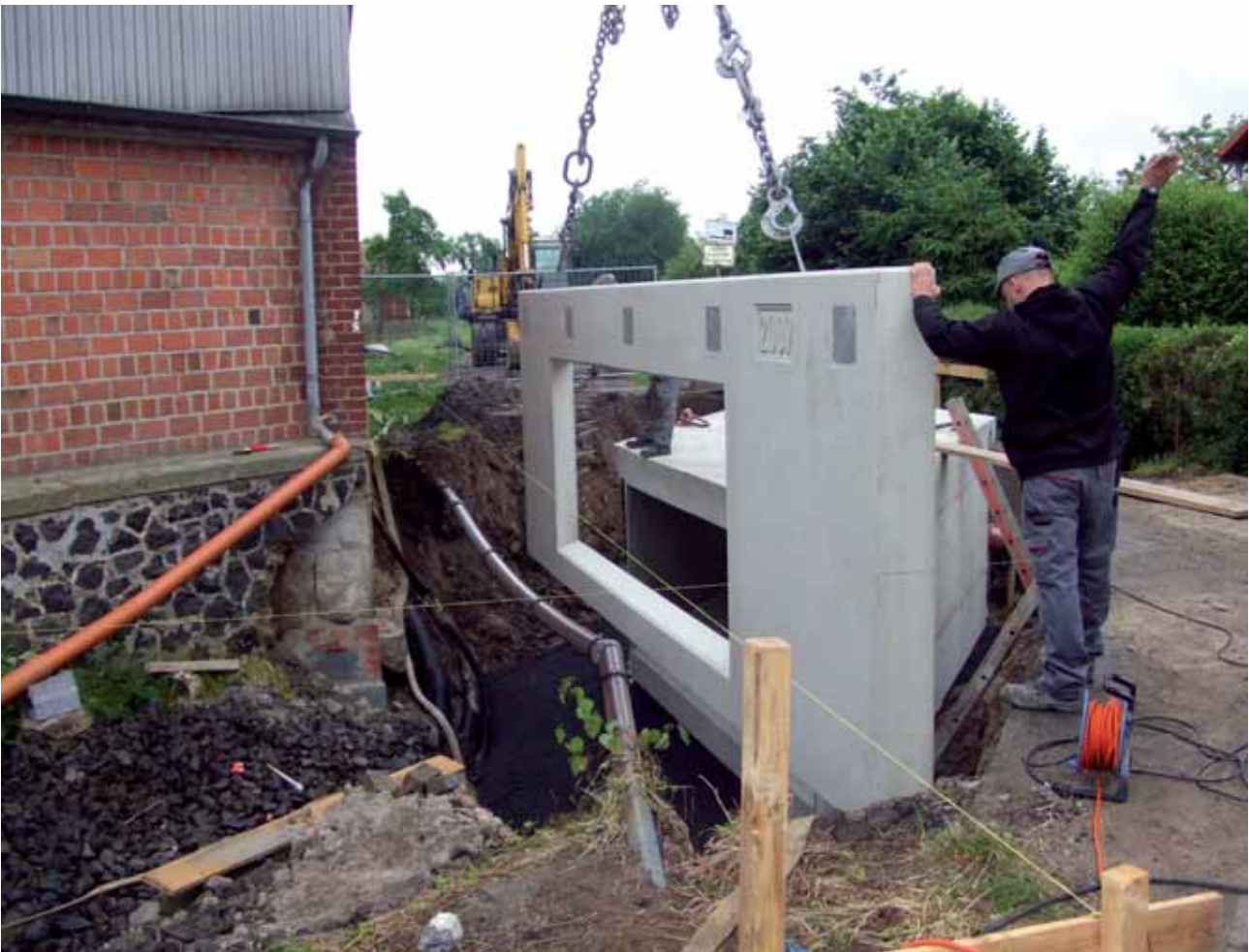
Einbau der ersten Flügelwand
