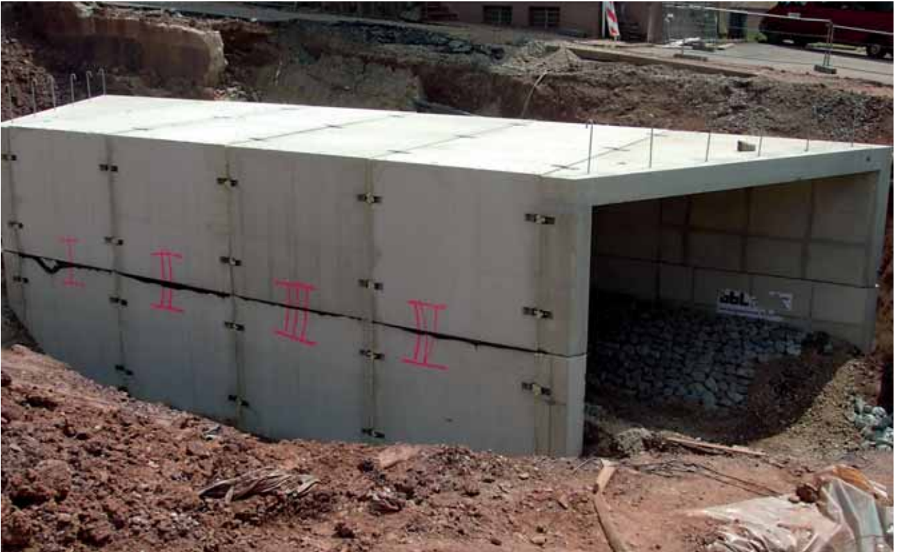
Fertig gestellter Durchlaß Montagedauer 1 Arbeitstag mit drei Monteuren
