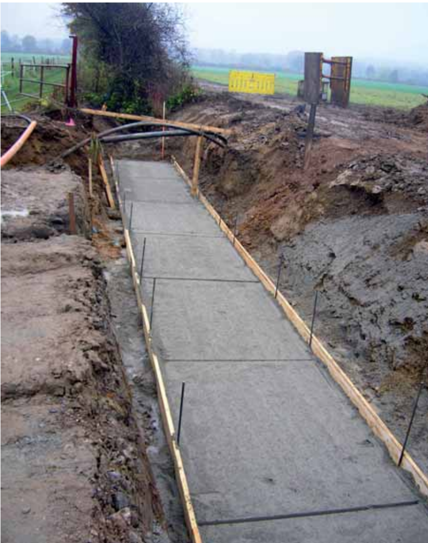
Vorbereitete Baugrubensohle mit Elektroleitungen
