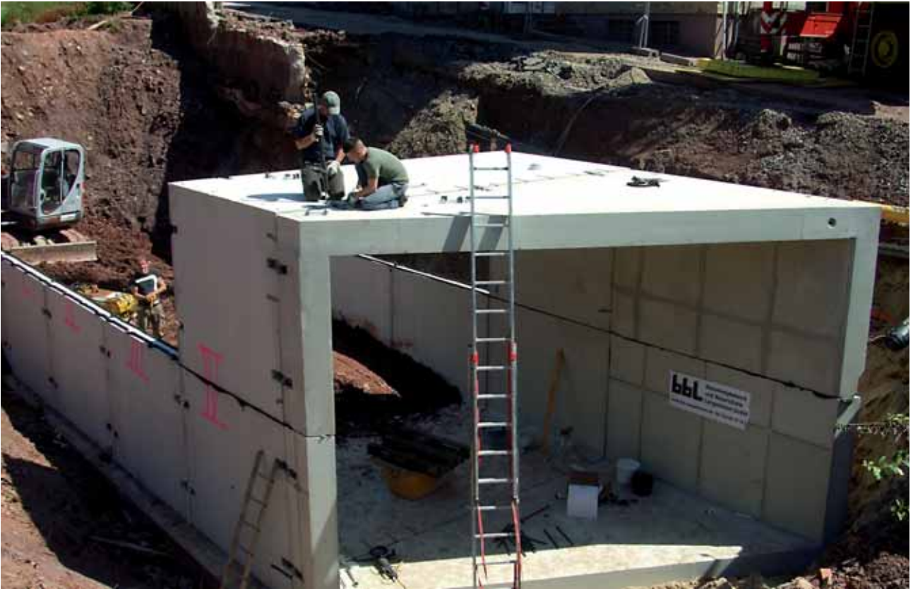
Einbau der U-Teile obere Lage
