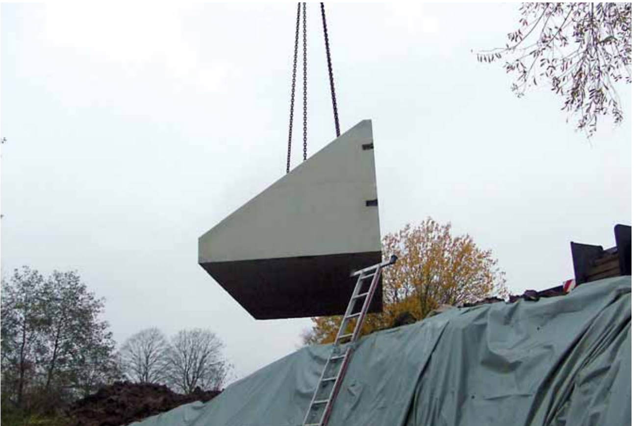
Einheben des ersten Böschungsstücks
