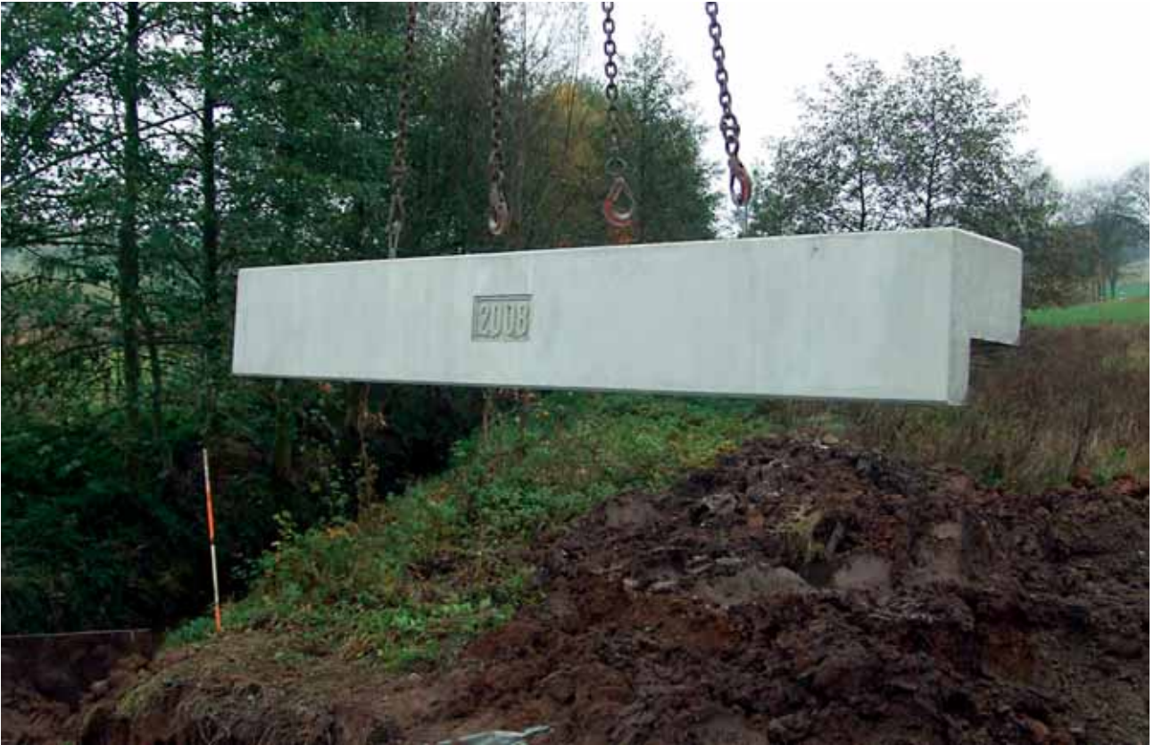
Einbau der Kappen
