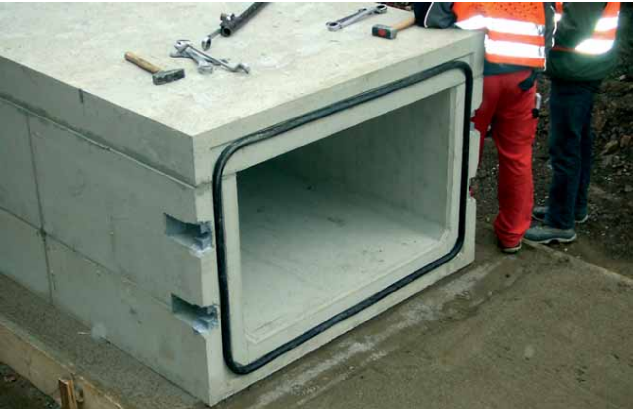
Letztes Teil auf Baugrubensohle mit aufgeklebter Dichtung und Spannschraubensätzen
