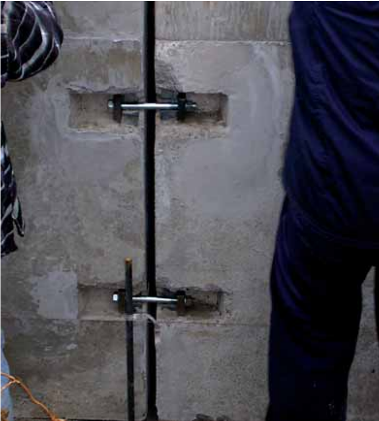
Beide Teile mit Spannschraubensätzen verbunden
