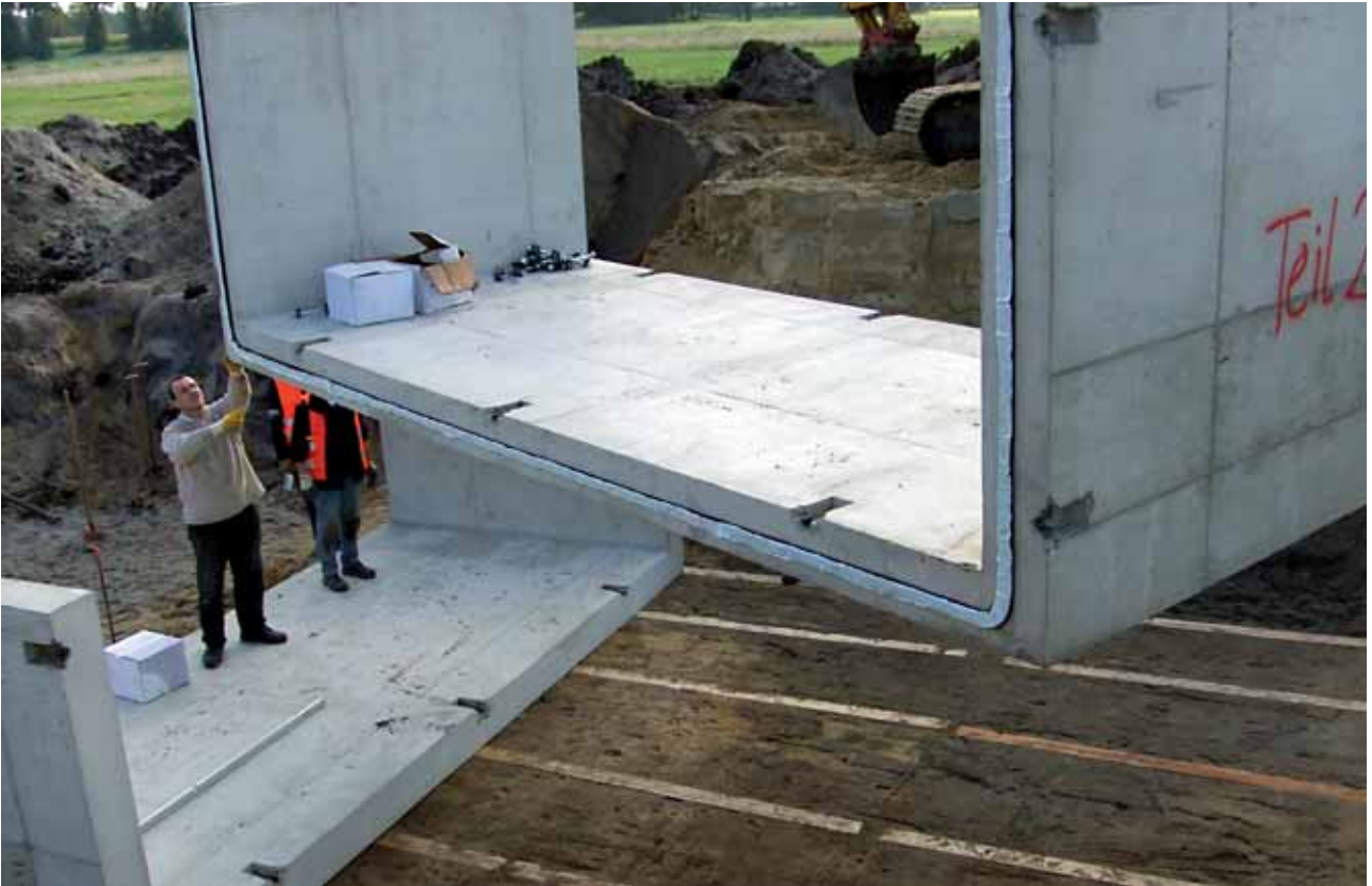
Einbau der U-Teile
