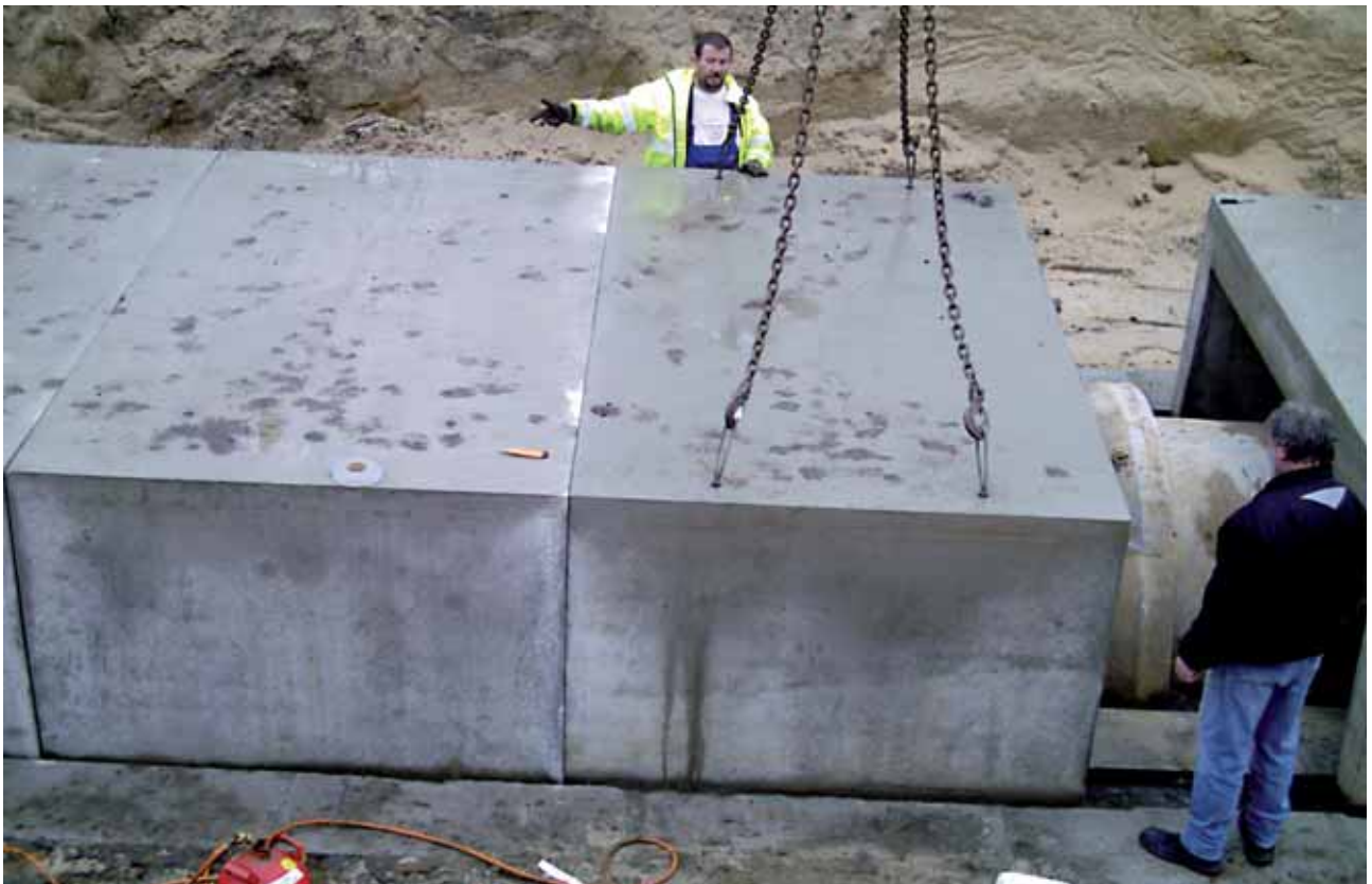
Teile werden stumpf gestoßen, Fugenausbildung plastisches Dichtungsband
