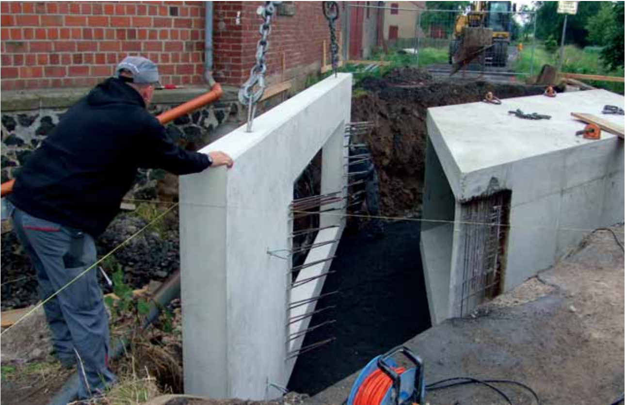
Einfädeln des Rahmenteils auf die Flügelwand unter beengten Platzverhältnissen
