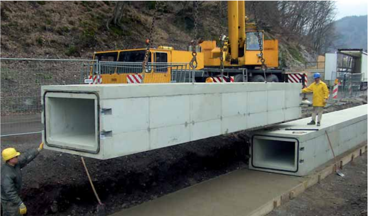
Einheben des nächsten Teiles
