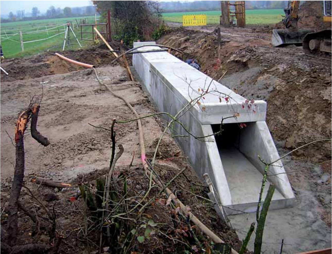
Bauleistung 19,00 lfm Rahmendurchlaß in 1 Stunde
