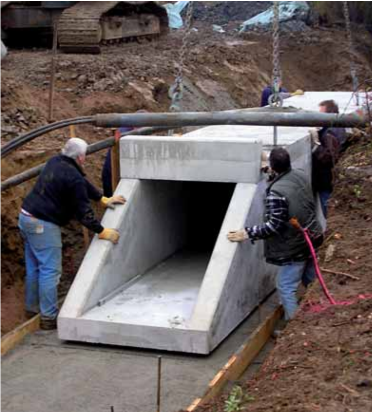
Einheben des ersten Bauteils
