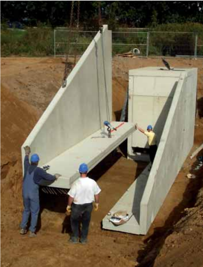
Einbau der Flügelwände mit Verspannung an das Bauwerk
