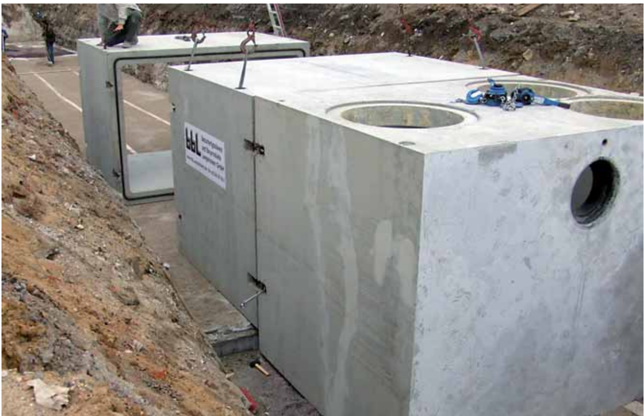
Vorbereitetes Rahmenelement mit aufgeklebter Dichtung
