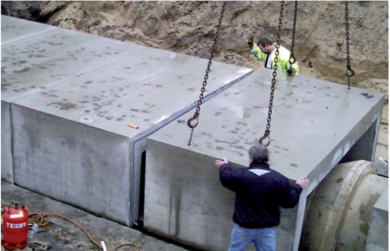
Teile werden stumpf gestoßen, Fugenausbildung plastisches Dichtungsband
