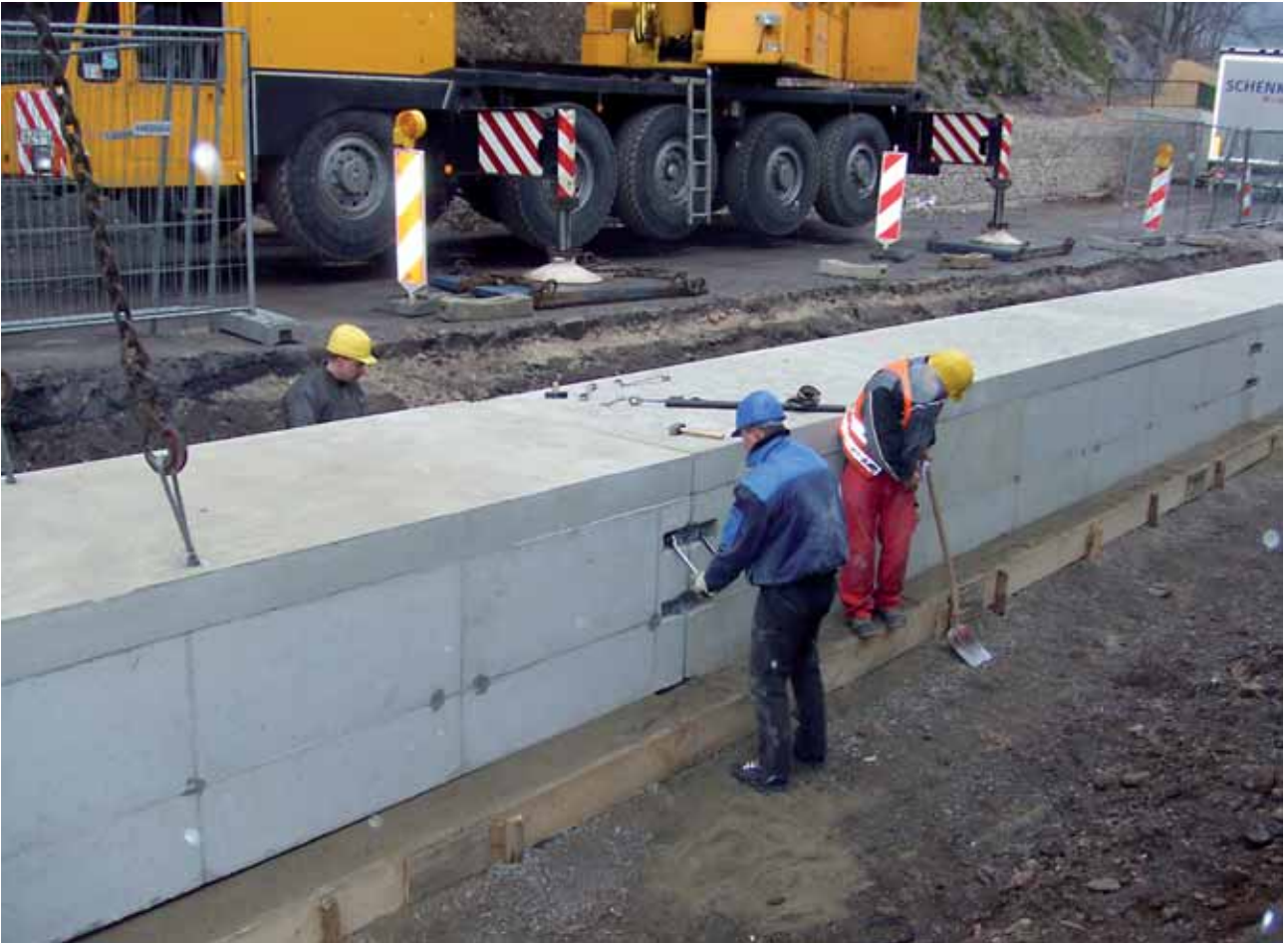
Spannschraubensätze festschrauben Verlegeleistung ca. 60 lfm in 4 Stunden.
