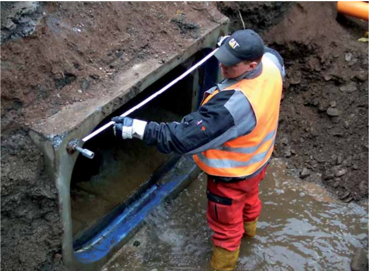
Aufmaß an bestehendem Kanal
