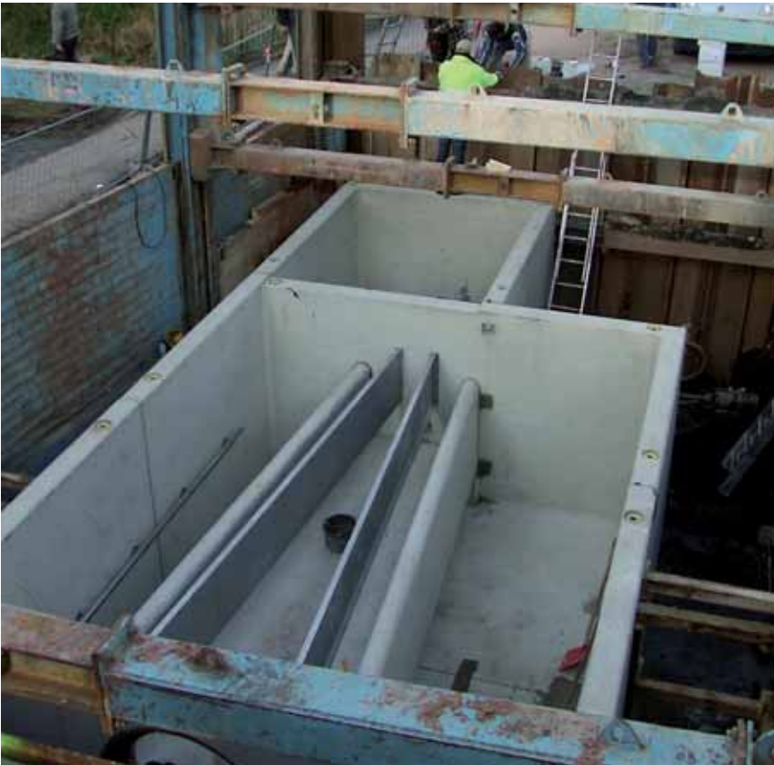
Waldkappel Überlaufbauwerk dreiteilig eingehangenes Fließgerinne, Edelstahlüberlaufschwelle, Abflußbegrenzer aus Edelstahl lichte Innenmaße l/b/h 500/400/250 cm
